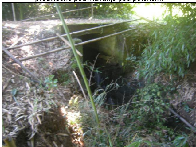
Premostitveni objekt na zahodnem delu območja, kjer je predvideno podvrtavanje pod potokom
