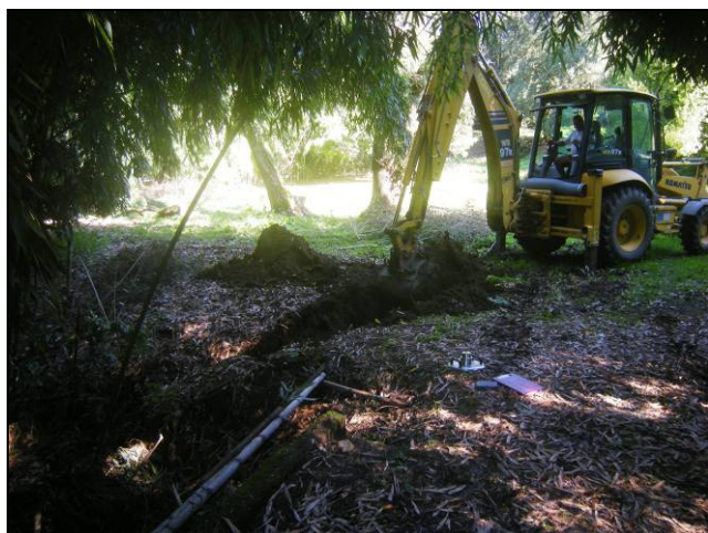
Lokacija sondažnega razkopa R2.
