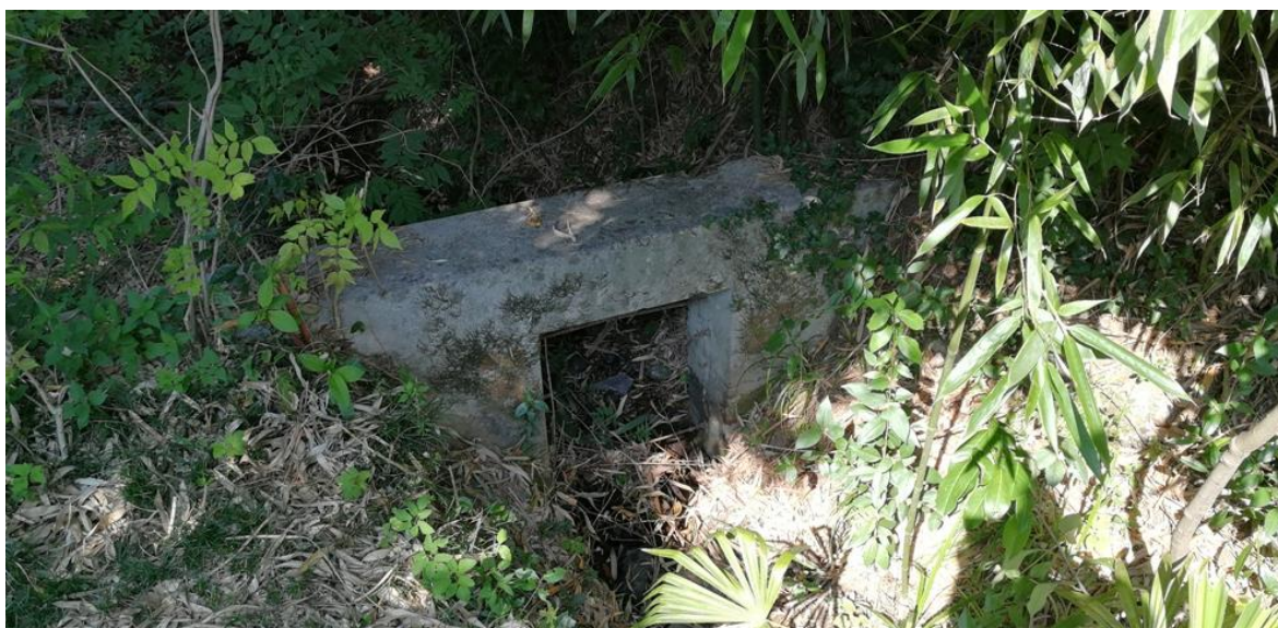
Slika 7: Betonski zid z odprtino
