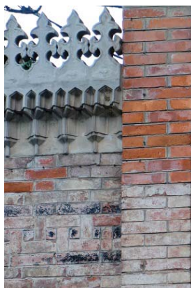
Slika 185, izguba barvnih plasti, izsoljevanje, prenova
