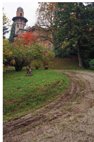
Slika 152, poškodbe makadamske pot zaradi vožnje z neprimernimi večjimi tovornimi vozili
