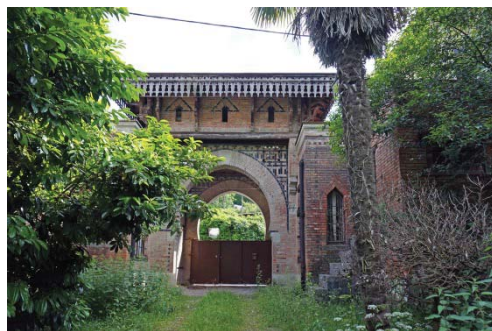
Slika 67, oznaka 4, vhodni objekt
