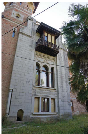
Slika 18, betonski zaidan del
