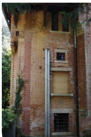
Slika 193, neprimerna rekonstrukcija, vidni madeži zaradi vlage, izguba barvnih plasti
