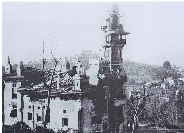
Slika 129, bombandiranje objekta, ki je poškodovalo večji del strehe in severno fasado, vir: Chiozza, Marco, 2005, Antonio Lasciac
