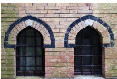
Slika 44, opečna dekoracija in betonski sklepnik
