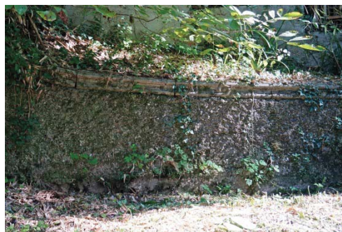
Slika 83, oznaka 19, oporni zid
