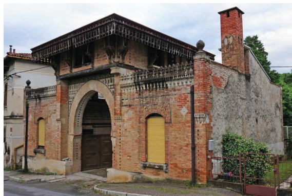
Slika 5, pogled na stransko fasado vhodnega objekta
