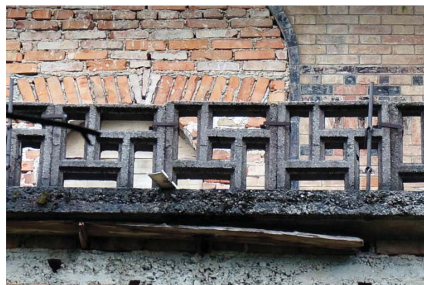
Slika 140, namesto lesene izrezljane ograje je uporabil dekorativno armirano betonsko, ki je že bila prisotna ob stolpu in na stolpu
