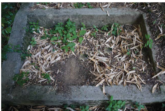
Slika 153, stopnišče oblikovano z betonskimi robniki in nasutjem
