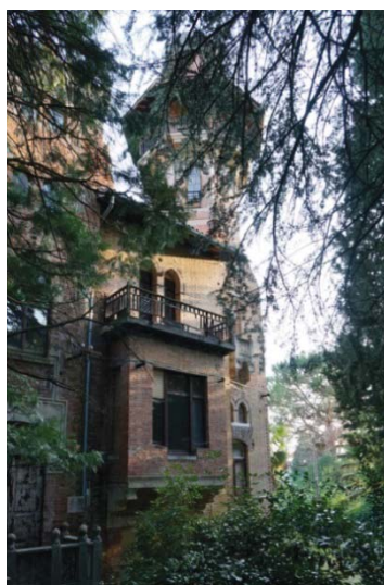
Slika 24, konzolni izzidek na južni fasadi
