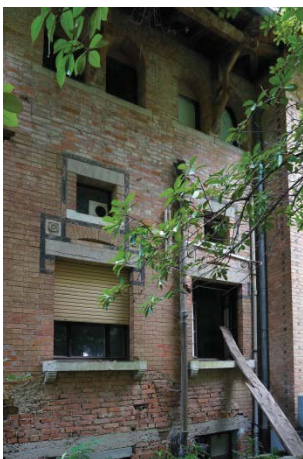
Slika 41, odprtine poudarjene z opečno dekoracijo in betonskimi elementi
