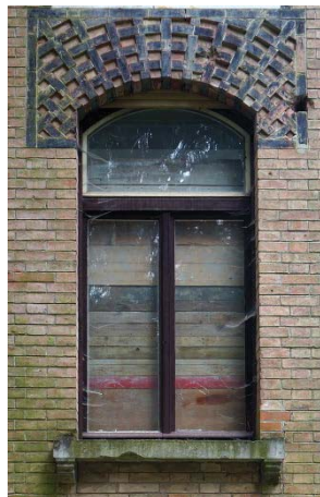
Slika 39, segmentno zaključeno okno z opečno dekoracijo
