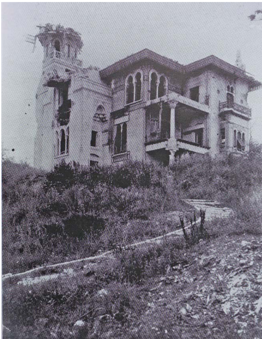
Slika 134, poškodbe na vili kot so porušen zgornji del stolpa, uničen lesen konzolni balkon, uničeni leseni francoski balkoni ter poškodovano rastje ob vili, vir: Chiozza, Marco, 2005, Antonio Lasciac
