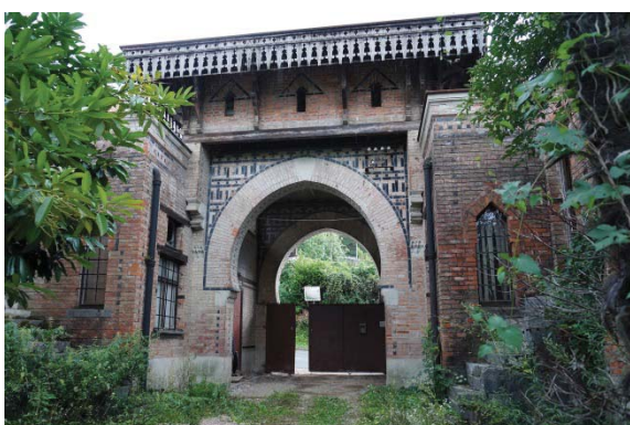
Slika 6, pogled na stransko fasado vhodnega objekta
