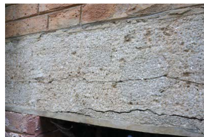
Slika 197, horizontalne razpoke na prekladi
