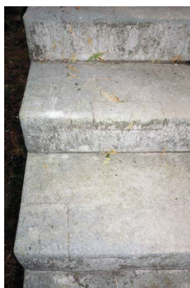
Slika 135, domodeliranje poškodovanih delov stopnic po prvi svetovni vojni
