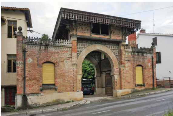
Slika 4, pogled na glavno fasado vhodnega objekta
