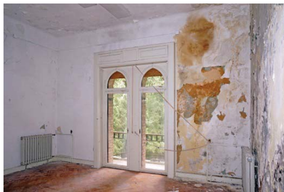
Slika 52, šilasto zaključena okna
