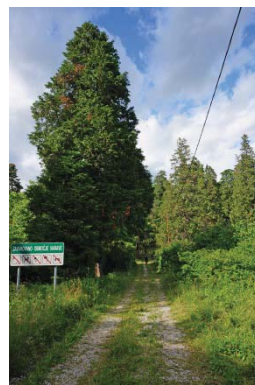
Slika 209, neprimerno postavljen napis ter električna napeljava
