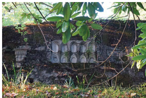
Slika 75, oznaka 11, oporni zid
