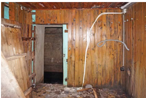
Slika 45, pogled na zbiralnik vode
