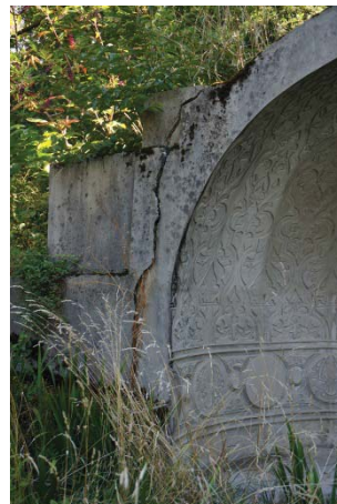
Slika 157, vidne vertikalne razpoke med kupolo in krajnima deloma
