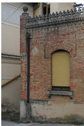
Slika 184, madeži, poškodba žleba, izguba materiala, barvnih plasti, mikrobiološka kolonizacija
