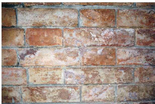
Slika 136, zapolnitev poškodovanih opek po prvi svetovni vojni
