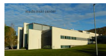
stavba medicinskega centra
