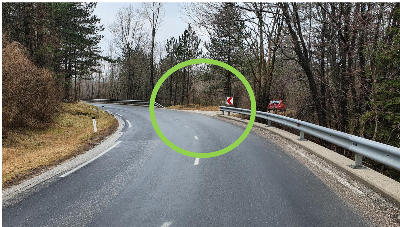
Fotografija 1: Pogled na obstoječ priključek
