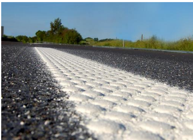
Slika: Taktilna ločilna črta iz materialov za debeloslojne označbe.
