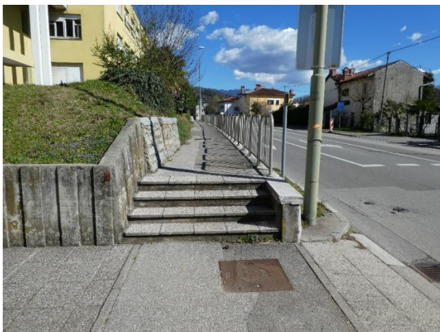
Slika: Dvignjen pločnik ovira prehod z invalidskim vozičkom na odseku, ki je pomemben za dostop do nekaterih objektov v Rožni dolini.
