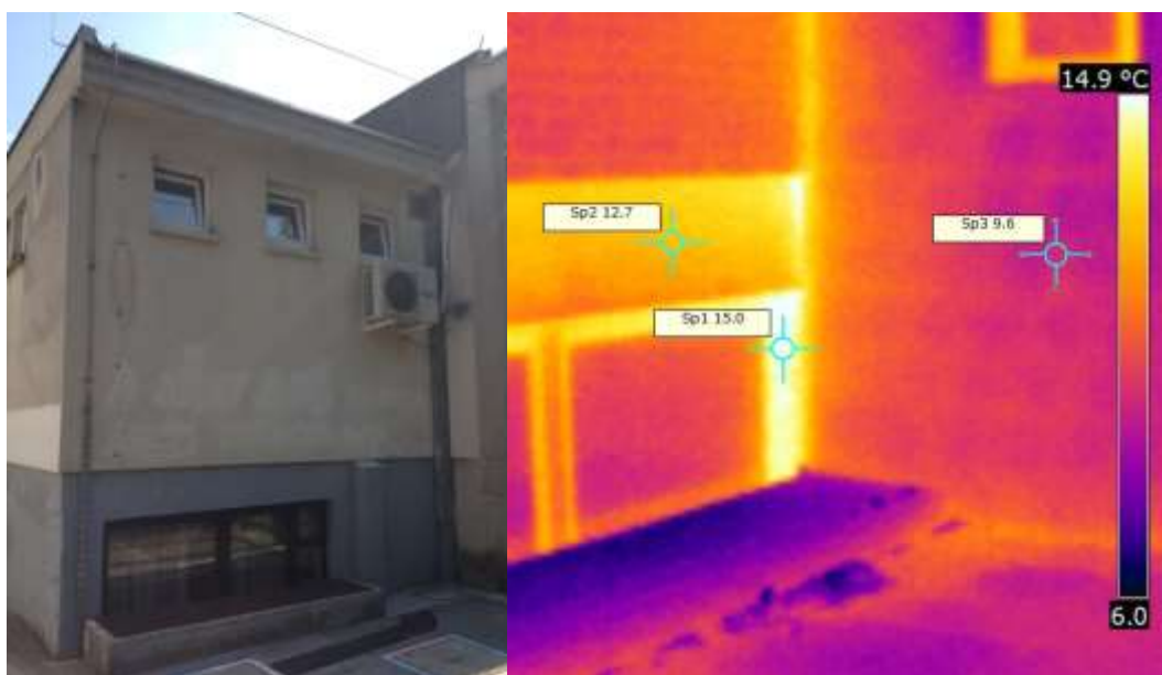
Slika 22: Kovinski okvirji oken (Centralni vrtec) (Razširjenem energetske pregledu Centralnega vrtca, 2012)
