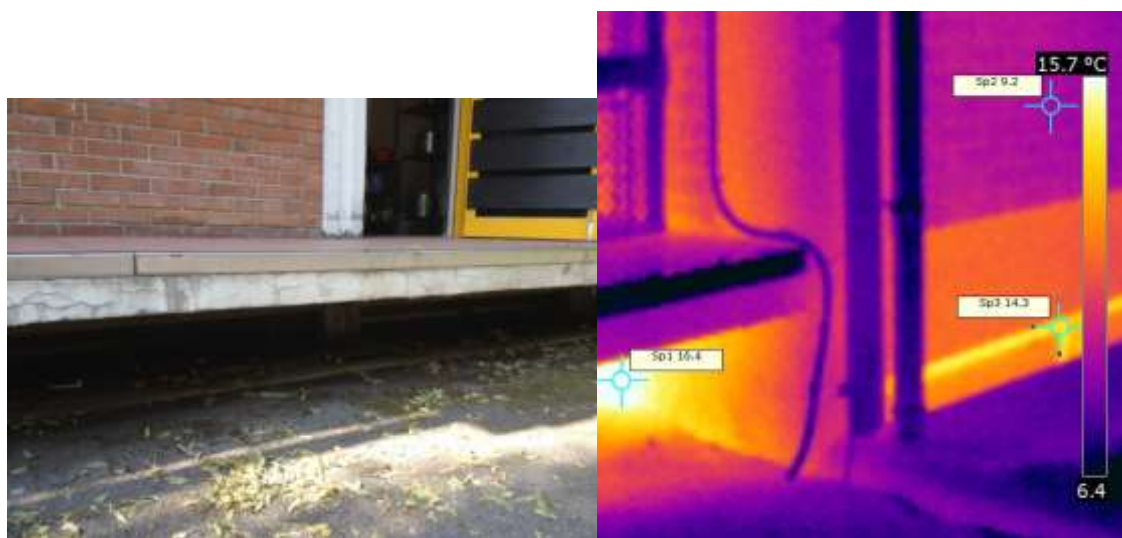
Slika 24: Kletni del stavbe (Centralni vrtec) (Razširjenem energetske pregledu Centralnega vrtca, 2012)
