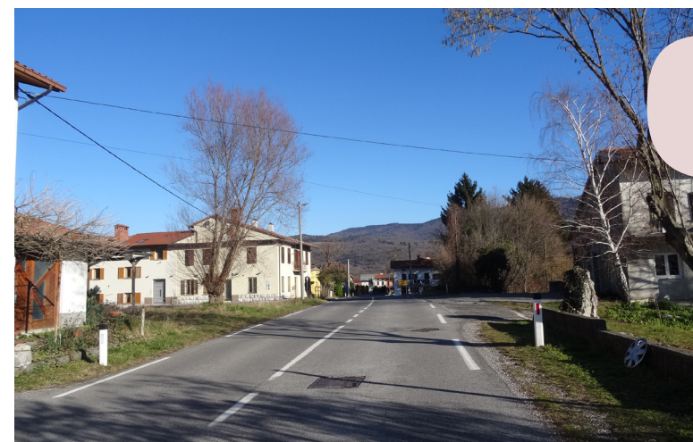
Pomanjkanje varnih površin za pešce ob glavni prometnici skozi naselje Grgar.
