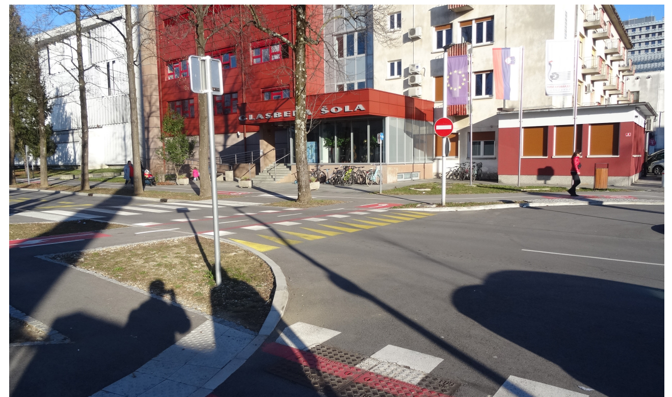
Urejen prehod za pešce in kolesarje pri glasbeni šoli.
