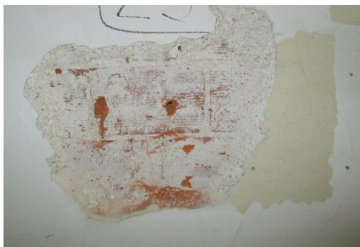
V preteklosti izdelana sonda na Z steni, ki kaže na pozidavo.
