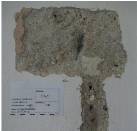
Sonda S60, prikazuje prisotnost primarnih plasti na desni strani sonde S60.
