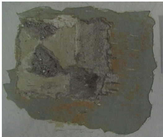
Sonda S57, ki nakazuje prisotnost odprtine.
