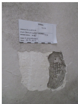
S24 na stropu.
