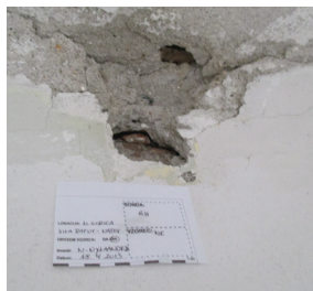
S11 na stropu.
