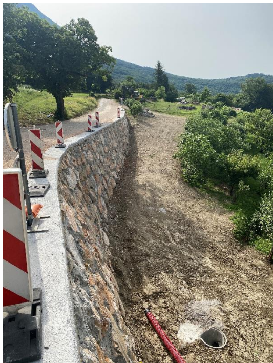
Slika 4 : Obnovljen nasip, voziščna konstrukcija in podporna konstrukcija
