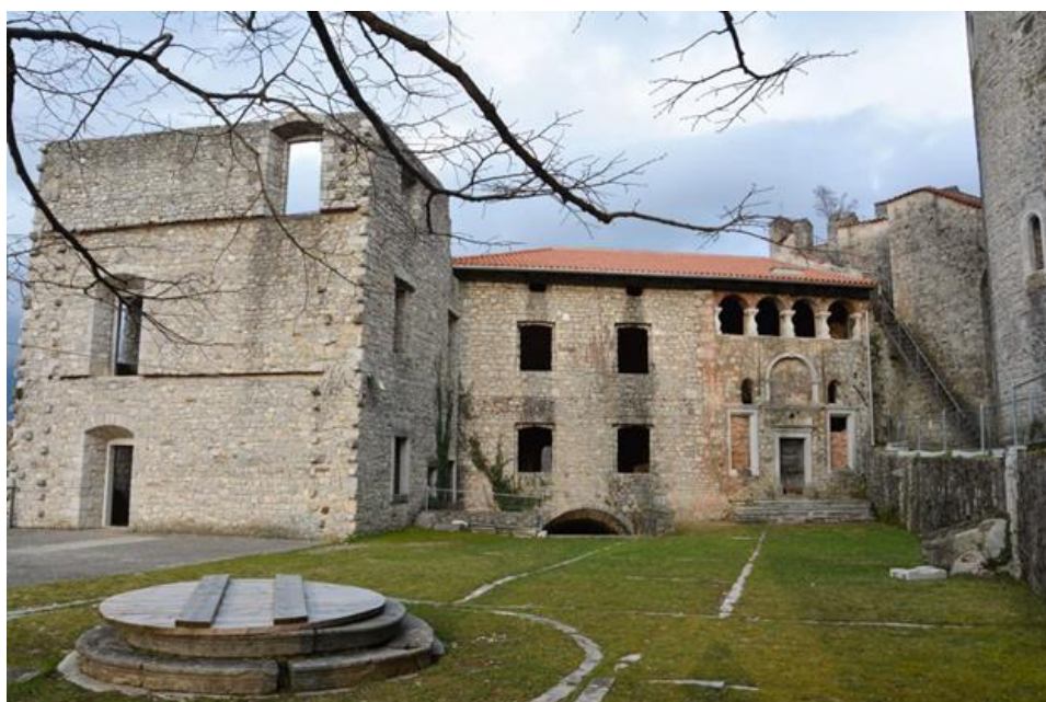
Slika 8: Obnovljena streha grajske kapele in sosednje stavbe
