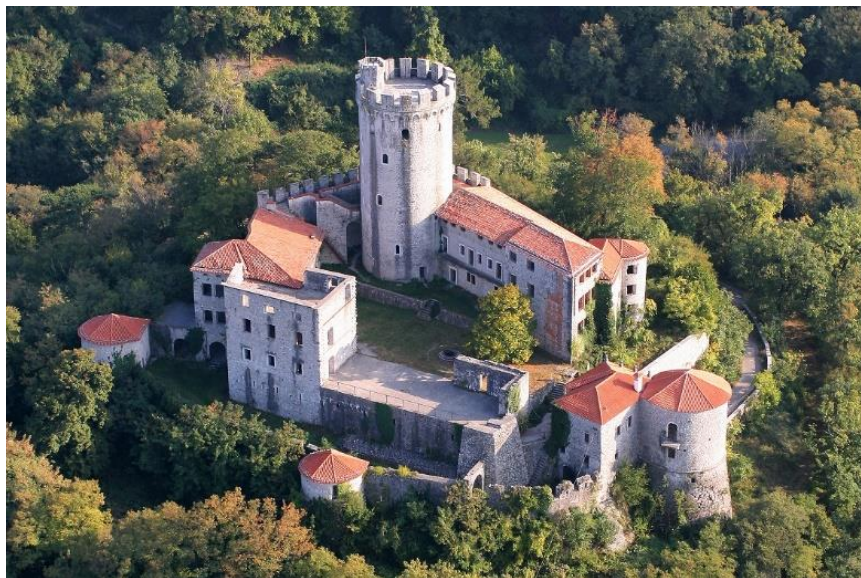
Slika 9: Grad Riheemberk pred obnovo streh, fasad in obzidij
