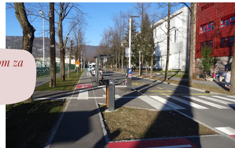
Kolesarska steza na Cankarjevi ulici.
