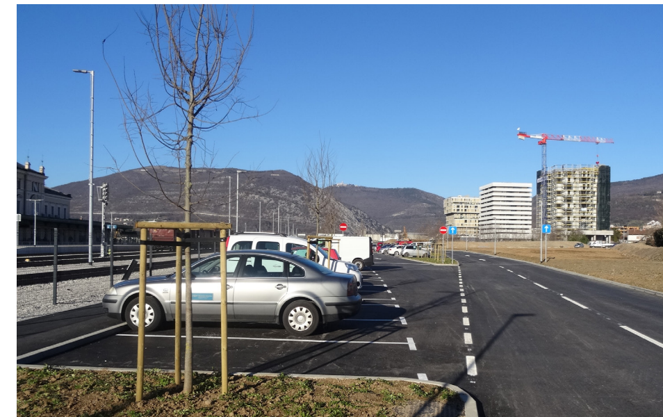
Novo parkirišče pri železniški postaji v Novi Gorici.
