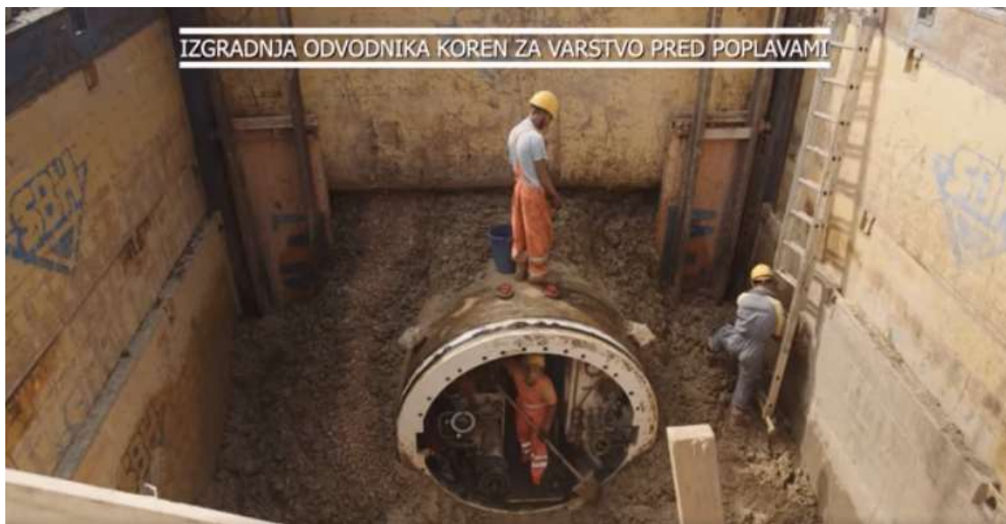
Slika 6.71: Vhodni del cevi razbremenilnika na lokaciji Erjavčeva cesta
