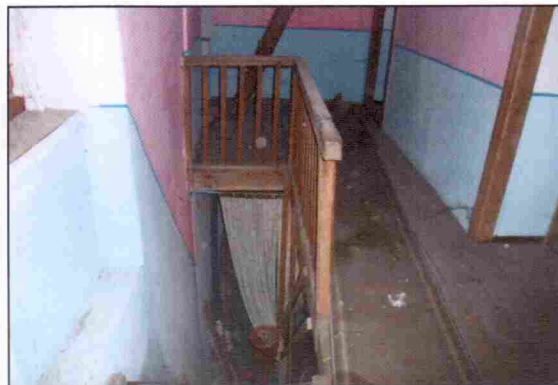
Hodnik v nadstropju
